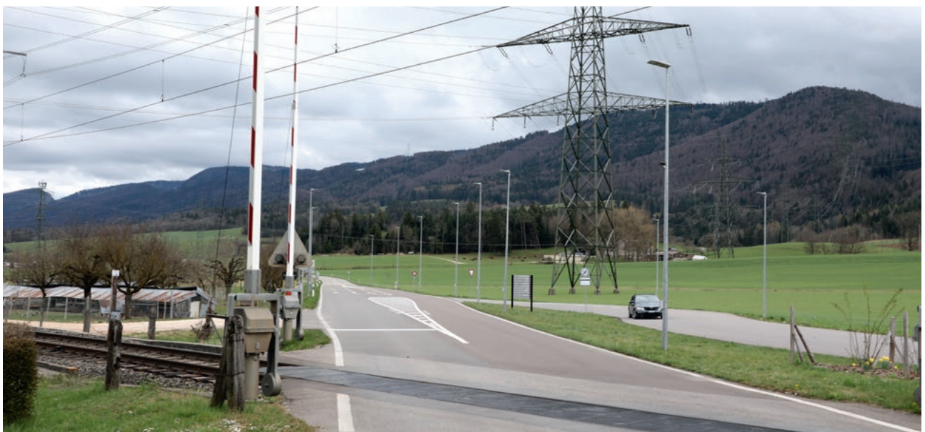
Foto Sichere Sanierung auch bei komplexen Situationen (nahe bei Eisenbahn und Hochspannungsleitungen)
